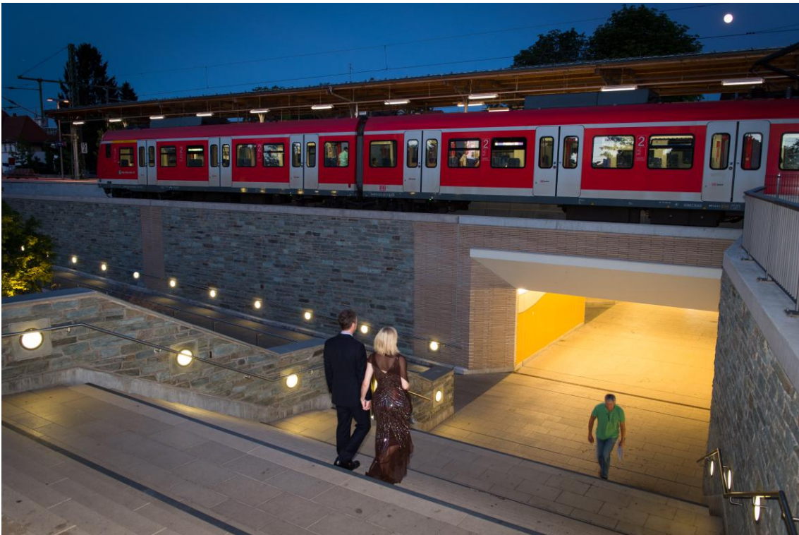
Auf dem Weg zur Alten Oper: Bei dieser Unterführung ist das eine reine Freude.
